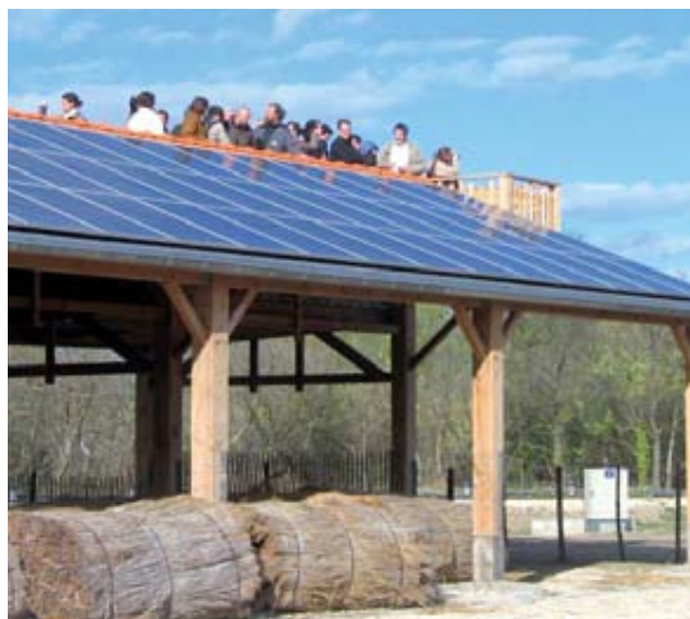
Chantier de toit photovoltaïque de 100 m 2 aux Marais du Vigueirat.
