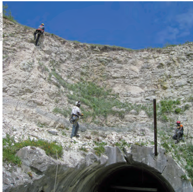
Pose du grillage pare-éboulis sur le front de taille au-dessus de l'entrée des souterrains sur la Réserve naturelle régionale de la forteresse de Mimoyecques par une entreprise spécialisée dans les travaux en hauteur. Cette opération répond à un double objectif de conservation du patrimoine géologique et de sécurisation : empêcher la chute de blocs sur les visiteurs et limiter le recul de la paroi.
