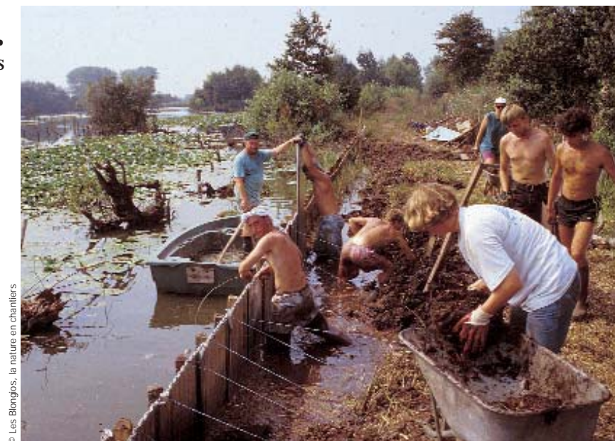
SITE DU ROMELAËRE • RESTAURATION DE BERGES
