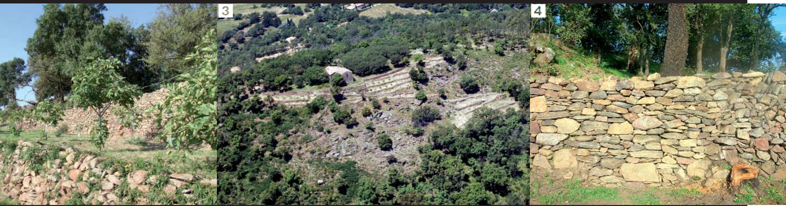
d'empreinte digitale. • 2. Plantation d'oliviers. • 3. Vue d'ensemble du jardin conservatoire. • 4. Réhabilitation des murs en pierres sèches.
