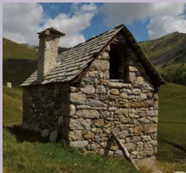
Cabane pastorale de la Terce Orcières. Une architecture de cueillette, inscrite dans son grand paysage. Seuls ici l'entretien courant et la restauration à l'identique de l'ouvrage sans modifications ni ajouts restent possibles.
