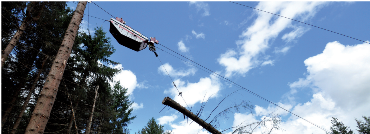
Un coût plus conséquent pour le débardage par câble-mât, largement compensé par l'absence de frais de remise en état du site.
