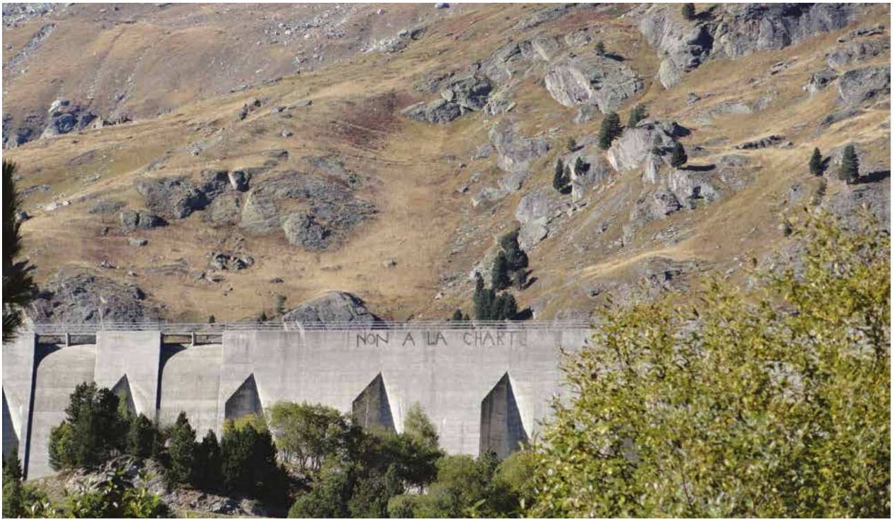
Graffiti sur le barrage de Plan d'amont (Aussois, Maurienne, Parc national de la Vanoise) inscrit après l'inauguration d'un nouvel aménagement des parkings au pied du barrage, destiné à mieux organiser les flux touristiques.
