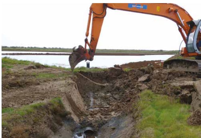
Mise à niveau du fossé en vue de la pose d'un batardeau en résine.
