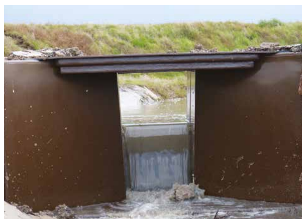
Remise en eau du système de batardeau.
