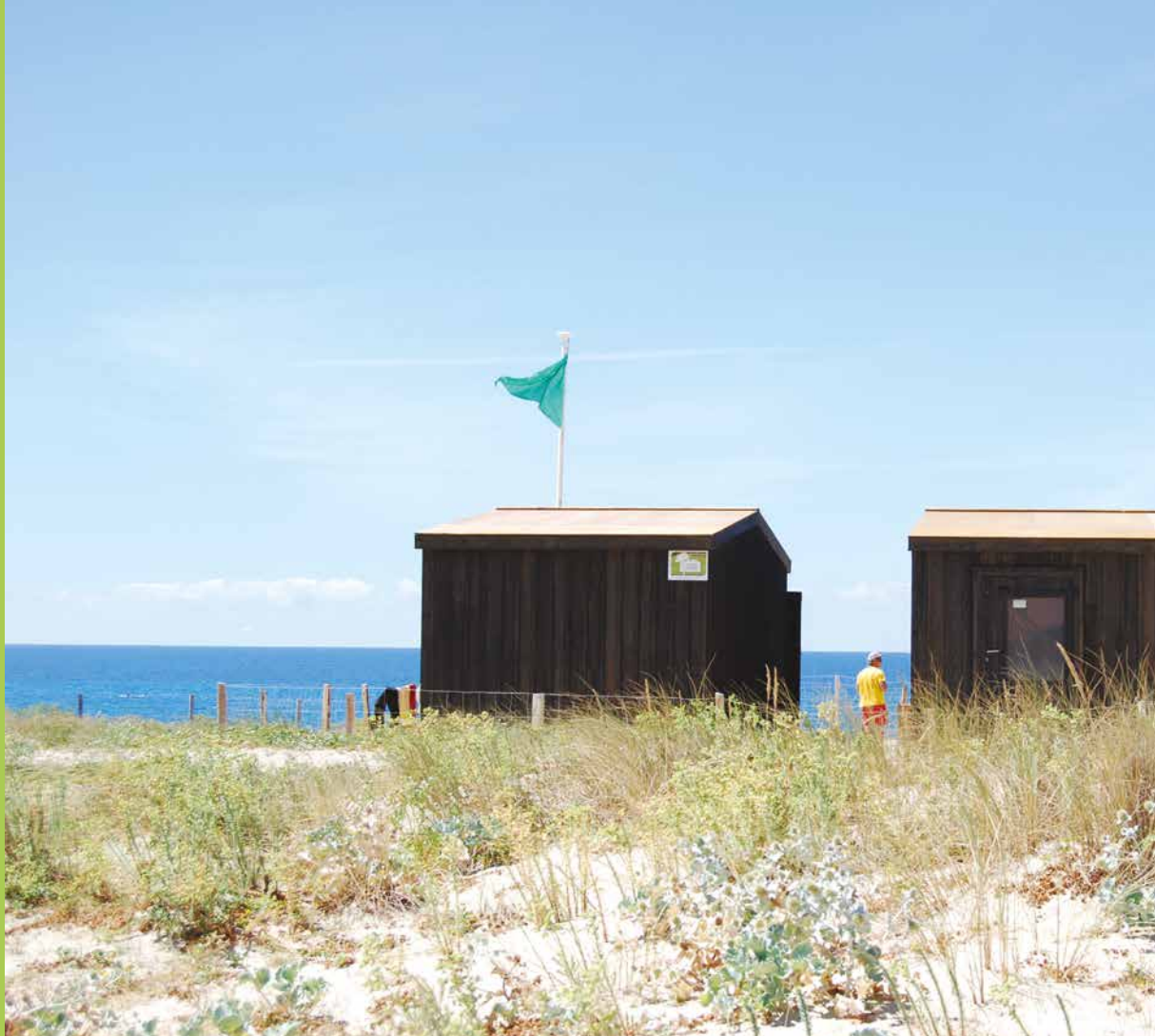
Les nouveaux postes de secours de Biscarosse en pin local ont remplacé les anciens préfabriqués inconfortables et inesthétiques.
