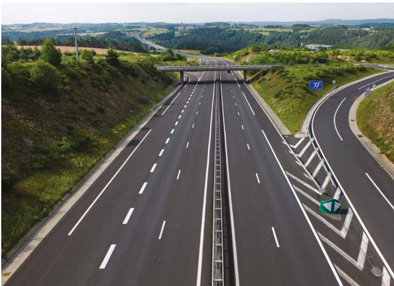
L'accroissement du réseau routier mondial est estimé à + 50 % d'ici 2050.
