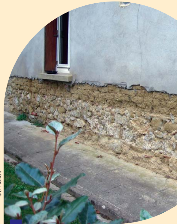
SAIGNÉE DE SAUVETAGE SUR UN MUR EN ADOBE DANS LE GERS ENDUIT AU CIMENT ET ISOLÉ DE FAÇON CONVENTIONNELLE. CETTE OPÉRATION D'URGENCE EN ATTENDANT UNE RÉHABILITATION DANS LES RÈGLES DE L'ART, RÉDUIT LES NUISANCES PAR LA POSSIBILITÉ D'ÉVAPORATION AU NIVEAU DU SOUBASSEMENT.
