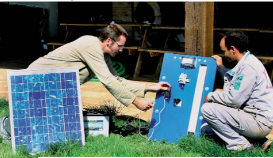
INSTALLATION DE PANNEAUX SOLAIRES SUR LA RÉSERVE NATURELLE DE L'ÉTANG DE LA MAZIÈRE.
